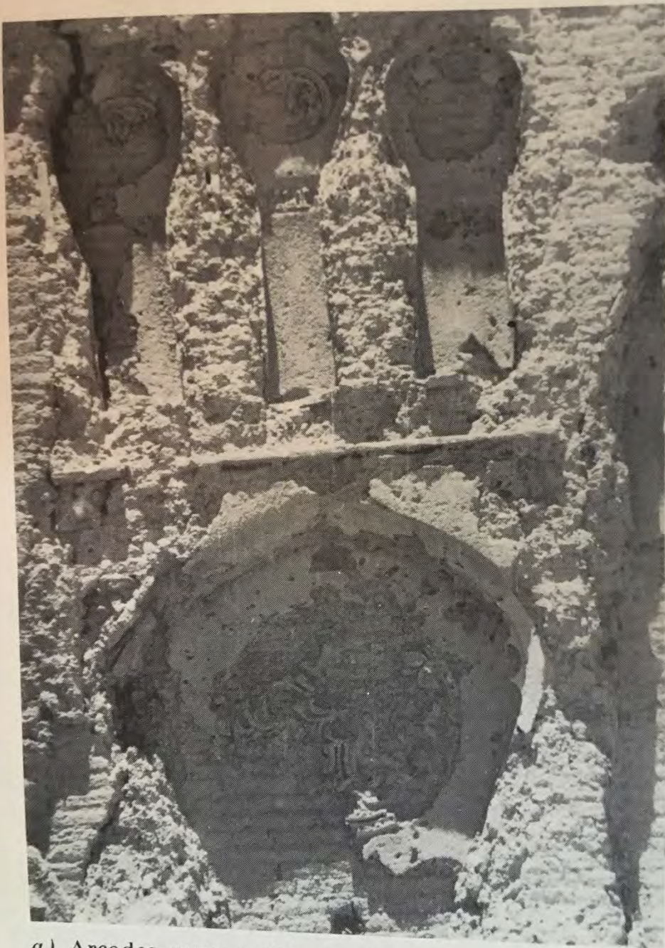
a) Arcades avec restes de stucs au voisinage de la tour Sud-Ouest.
