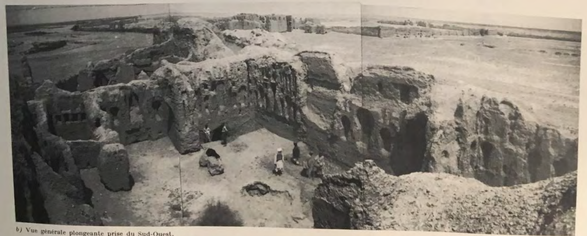
b) Vue générale plongeante prise du Sud-Ouest.
